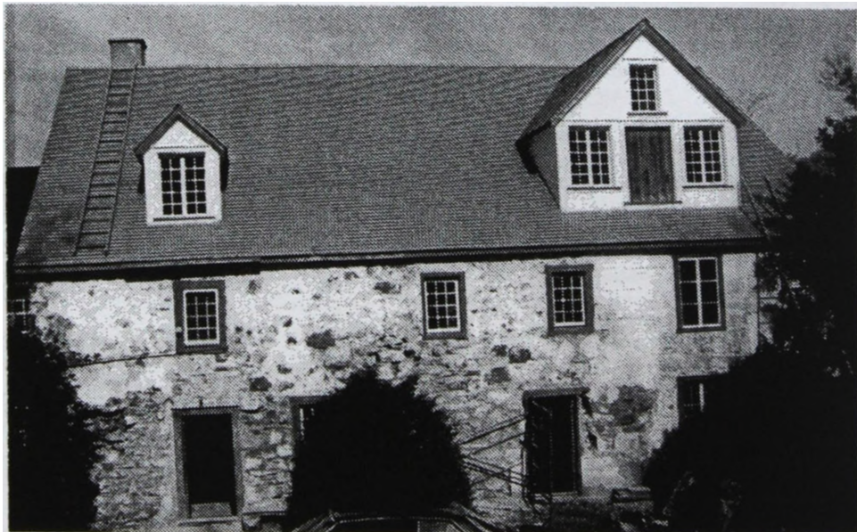
Le vieux moulin après la réfection de la toiture en 1993.
