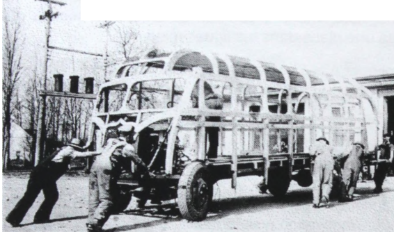
Ossature charpentée en merisier sur un bâti de camion
