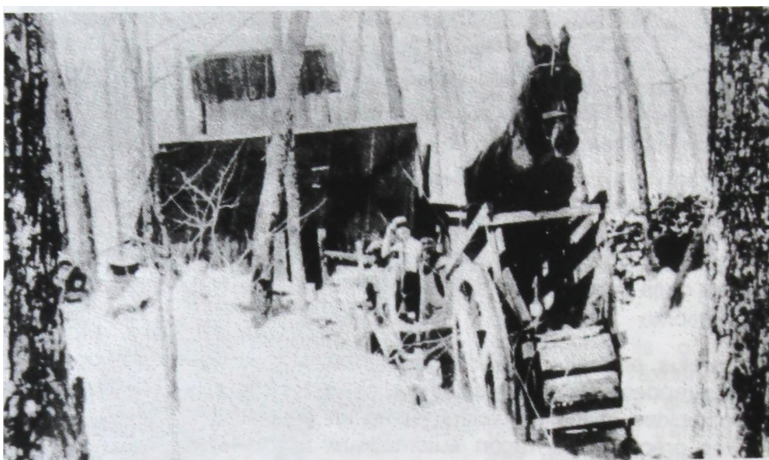
M. Joseph Fauchon, père de feu Bertrand décédé récemment. Sciage du bois à l'aide d'un horse power, à la cabane à sucre. Doit dater des environs de 1920. Collection : Laval Fortier
