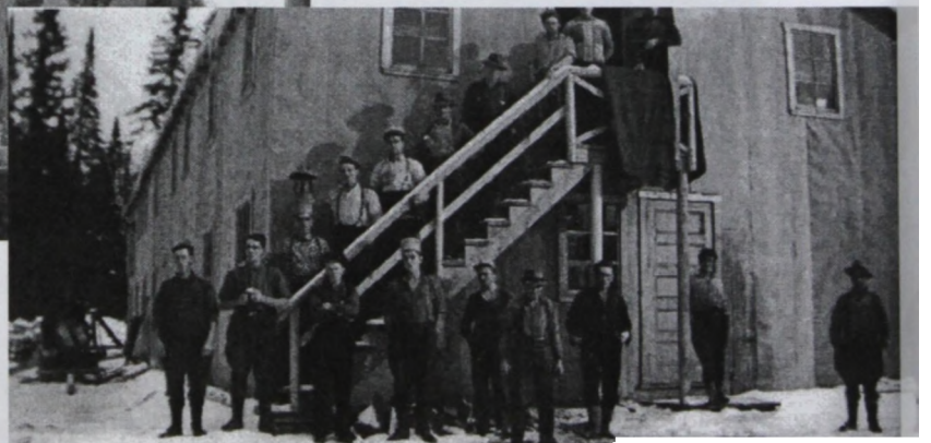
Un des nombreux chantiers des Duchesneau.
