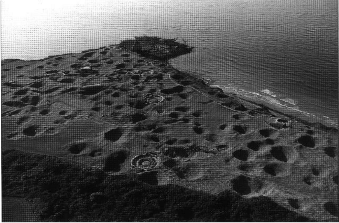
Pointe du Hoc : Les multiples cratères creusés par les bombardements aériens témoignent de la violence des combats qui se déroulèrent en Normandie au printemps de 1944 .
