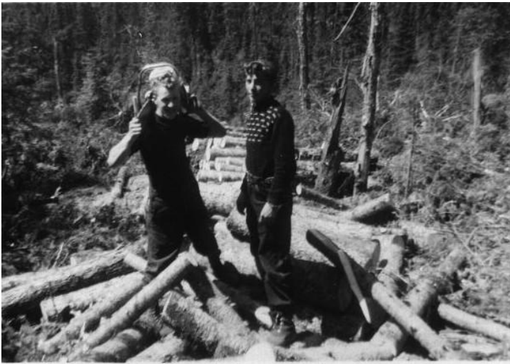
Sa scie mécanique sur les épaules, Raymond pose ici avec son cousin Sauveur dans un chantier de Shipshaw
