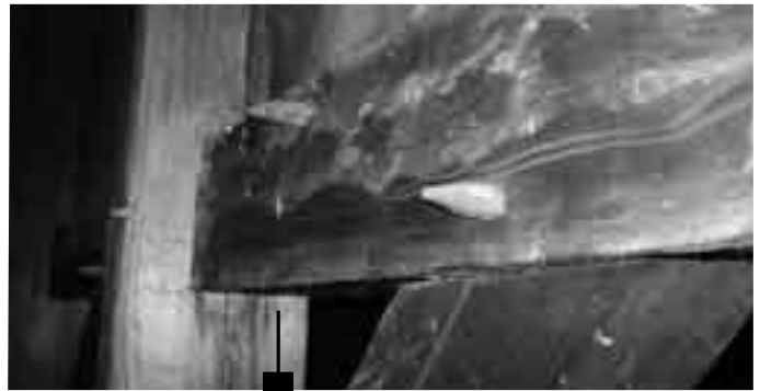
Clous de bois servant à assembler la structure de l'église.
