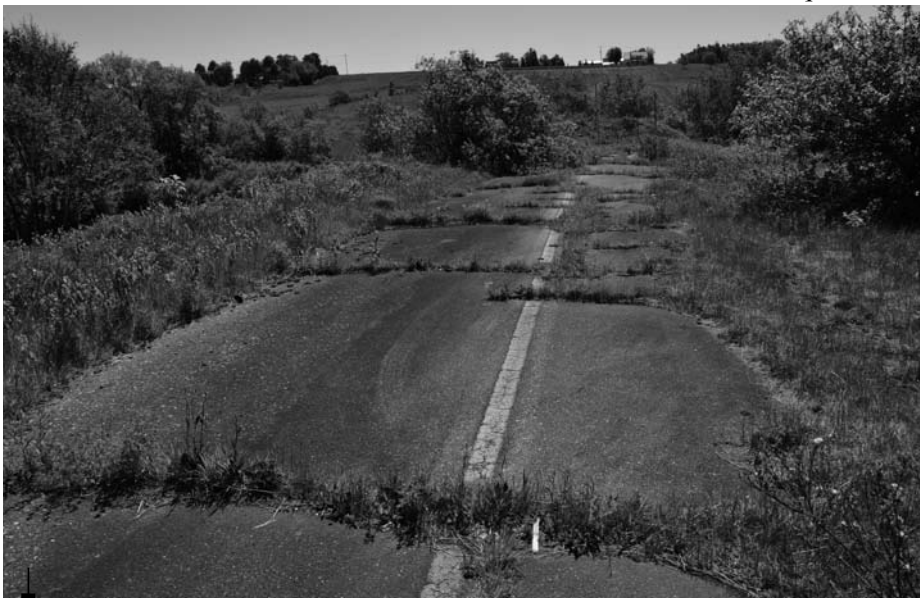
Route Chabot à Saint-Charles – Photo de l'auteur
