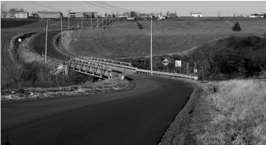
Route Picard à Saint-Charles - -Photo de l'auteur
