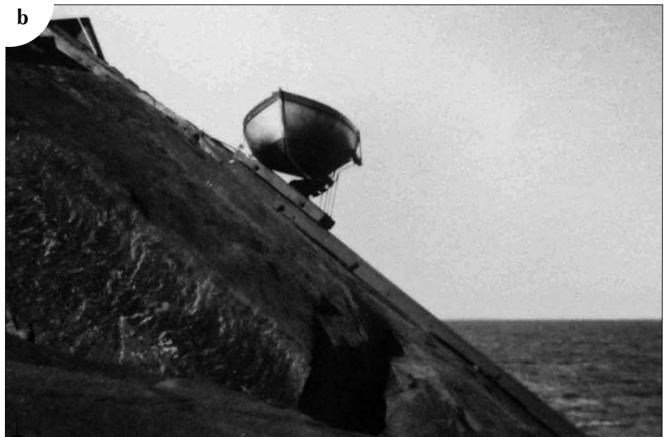
a/ Le côté Sud du phare avec le slip et la chaloupe. À remarquer les billots de bois de chauffage récupérés et cordés en haut du roché. b/ Chaloupe sur le traîneau du slip pour la mise à l'eau. Photo : Collection Jean-Louis Gaumond
