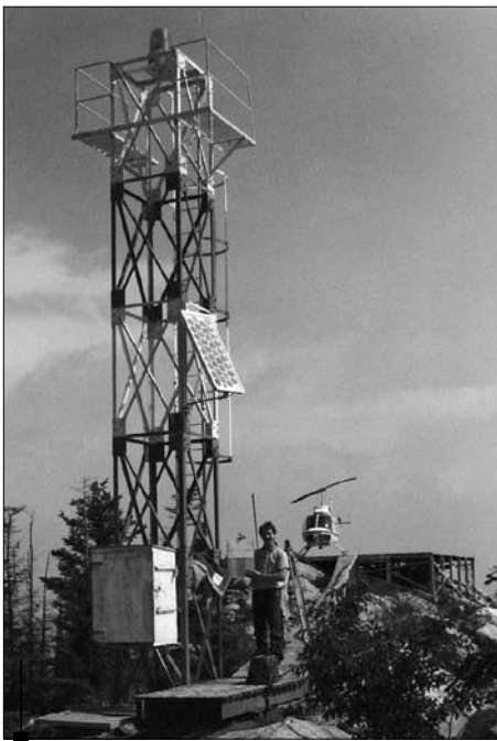
La tour à claire-voie de l'île de Bellechasse dans les années 1980. Photo : Archives Garde Côtière de Québec
