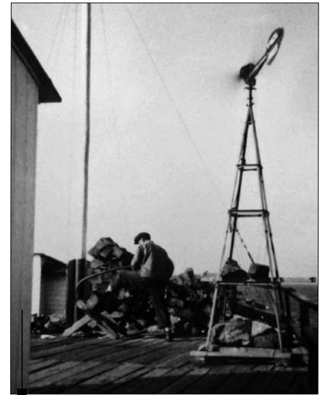
Le gardien Lauréat Gaumond faisant du bois de chauffage. Petite éolienne à proximité du phare pour recharger les batteries du radiotéléphone. Photo : Collection Jean-Louis Gaumond
