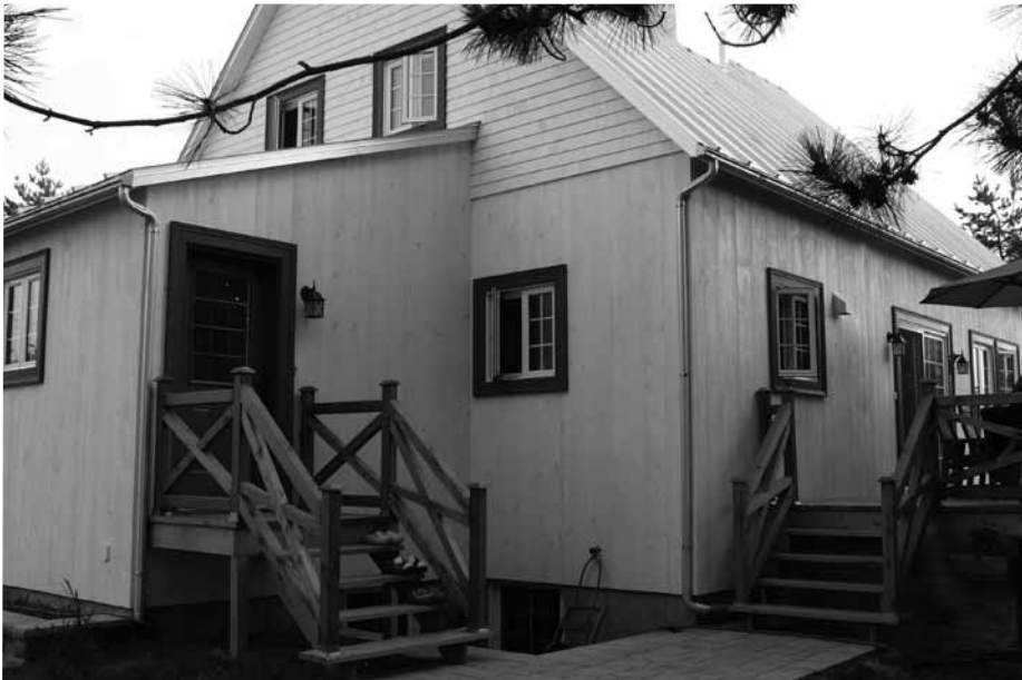
Revêtement de planches à la verticale, bardeaux de cèdre, et tôle à baguettes en toiture
