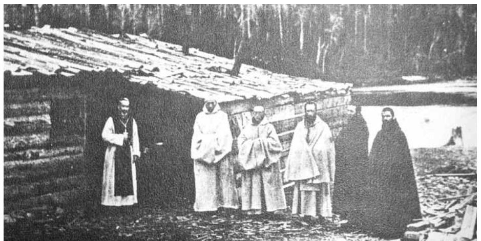
Cette photo prise en 1892 montre bien la rusticité des 1 ers établissements cisterciens au Québec.
