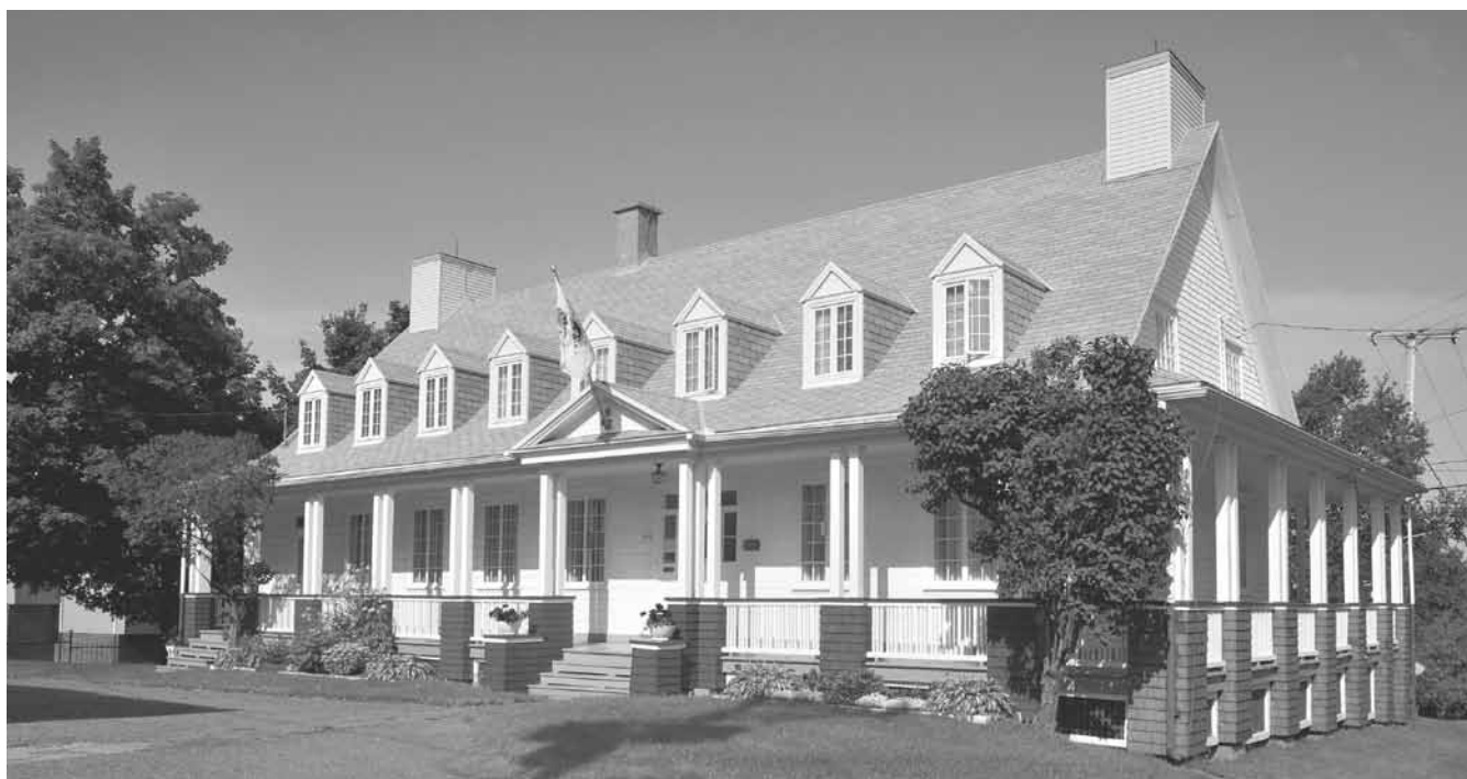
Le presbytère de Saint-Vallier, spécimen évolué de la maison « canadienne ». La toiture avant compte à elle seule huit lucarnes et son arête est percée de deux cheminées en pierre. Ph. Yvan Gravel
