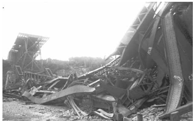
Photo prise peu après l'effondrement du premier pont de Québec. Photo de Fred C. Würtele, BANQ P546D6P75.
