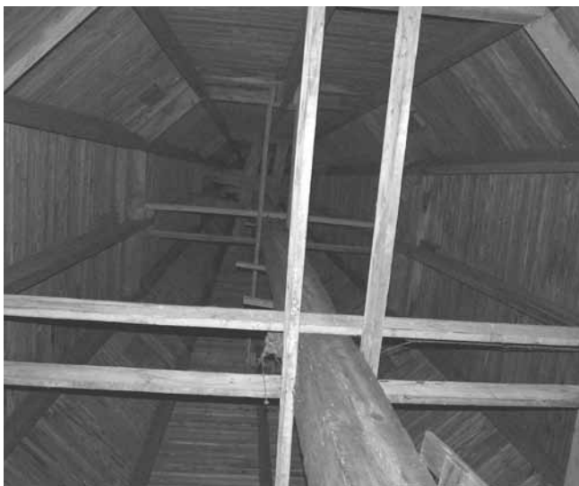
L'ascension de l'intérieur de la flèche se fait d'abord par une échelle branlante, laquelle mène aux échelons fixés directement dans la pièce centrale.
