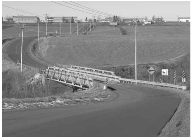
Pont Picard à Saint-Charles-de-Bellechasse
