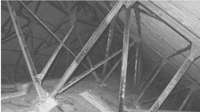
Les combles de la nouvelle église sont occupés par un enchevêtrement de fermes d'acier tandis que les enveloppes externes et internes sont à treillis enduit de mortier, la couche interne étant isolée de laine de verre. Collection Pierre Prévost, juin 2011.
