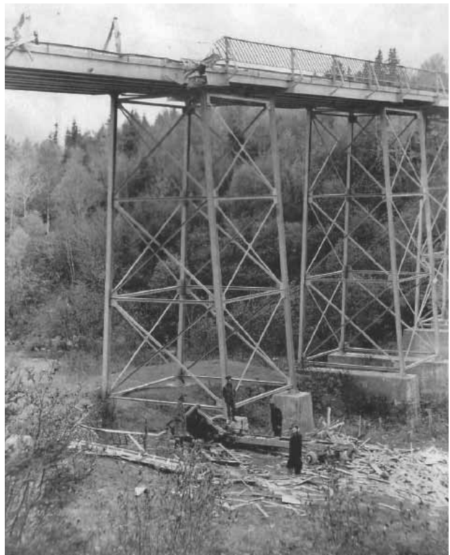
Le pont et les débris de l'accident
