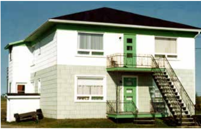
L'ancienne école No. 7 située près de l'intersection du chemin Jean-Guérin Ouest et de la route du Président Kennedy.
