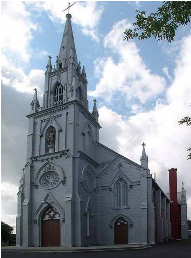
L'église Sainte-Emmélie de Leclercville reflète le courant néogothique tant à l'extérieur avec ses ogives, ses contreforts, ses épis, qu'à l'intérieur par ses colonnes fasciculées, ses arcs en tiers point et sa voûte de chœur à nervures. Photo de l'auteur, 2011.
