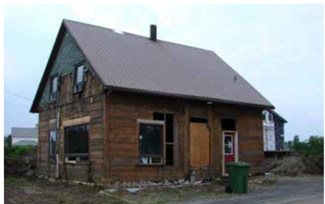
L'ancienne école No. 3 en cours de démolition, à la fin de l'été 2009, à l'intersection du chemin Saint-Jean-Baptiste et de la route du Président Kennedy
