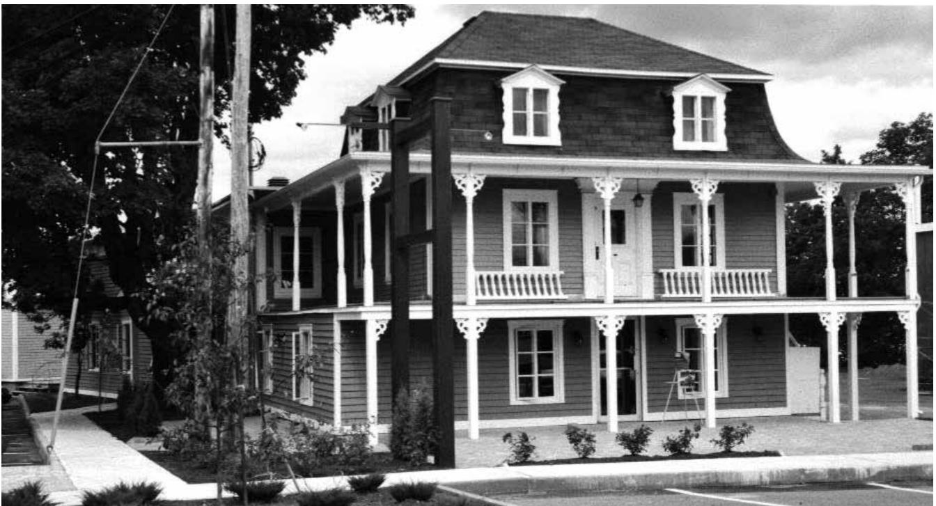
Quincaillerie Turcotte après restauration
