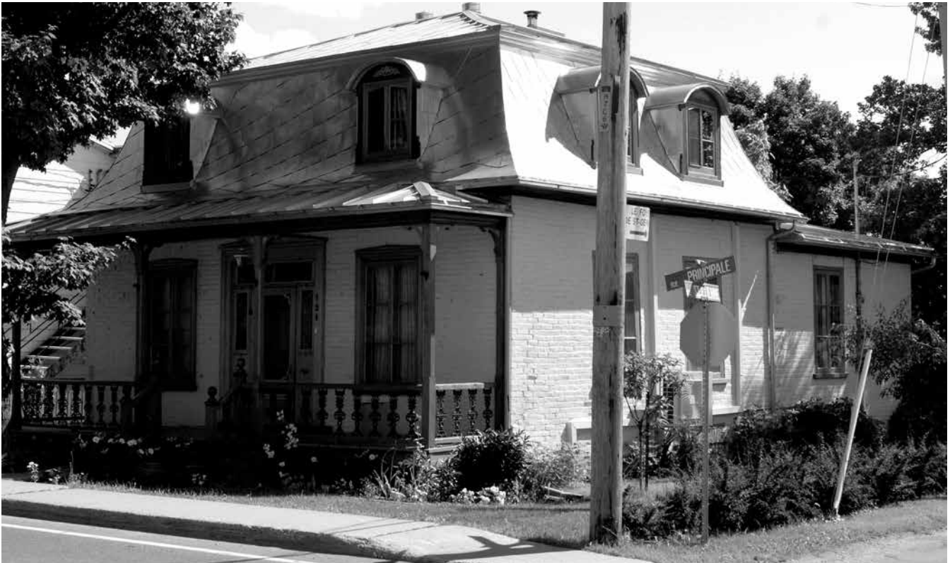
Pauline Tremblay et Armand Gagnon ont redonné un second souffle à la coquette maison où ont habité les demoiselles Paré pendant près d'un demi-siècle. Le «bas-côté» a servi de succursale à la Banque Canadienne Nationale pendant quelques années.
