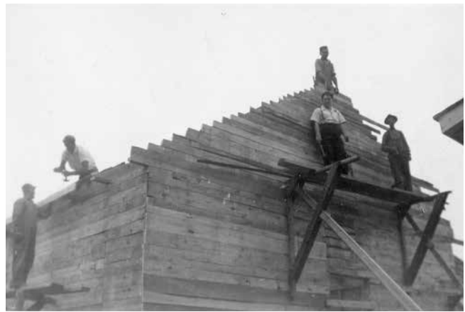
Construction du hangar à grains
