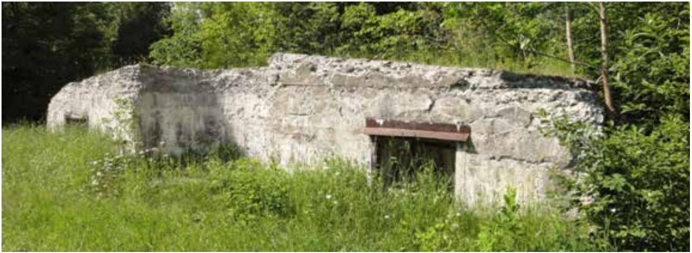
Une casemate, également appelée bunker, est un ouvrage renforcé en béton, partiellement enterré, qui fait partie d'une fortification ou d'un fort, pour placer l'artillerie à l'épreuve des tirs ennemis. Le Fort de Beaumont en compte deux construits selon la même architecture. (Photo : Société historique de Bellechasse 2013)
