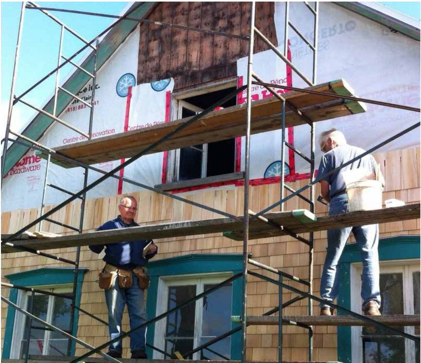
Pierre Lefebvre et Jean-Pierre Lamonde terminent septembre 2015 la pose des bardeaux au mur ouest de l'école. Ph. J.C. Tardif
