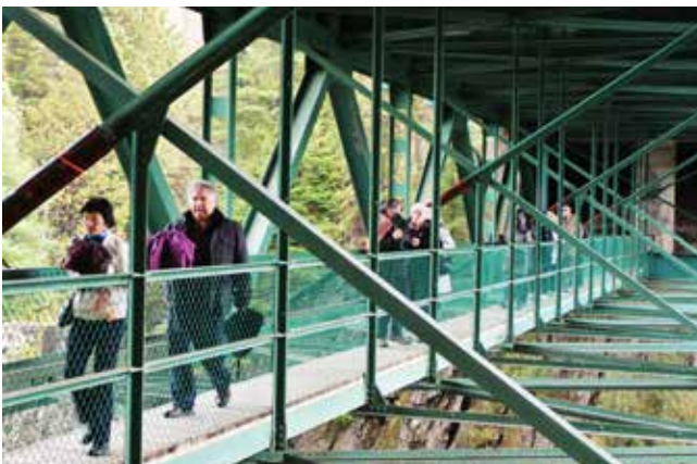
Sous le tablier du pont routier, les excursionnistes ont pu contempler le site de l'ancienne centrale hydroélectrique d'Armagh.
