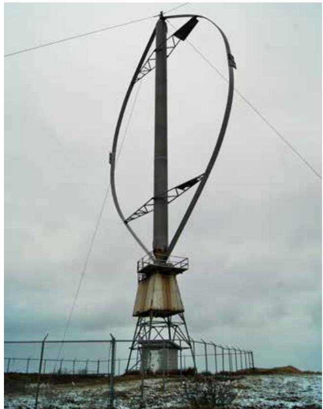
L'éolienne de type Darrieus est encore en place au site de la Cormorandière aux confins nord de l'île du Havre-aux-Maisons. Photo de l'auteur, 2015.
