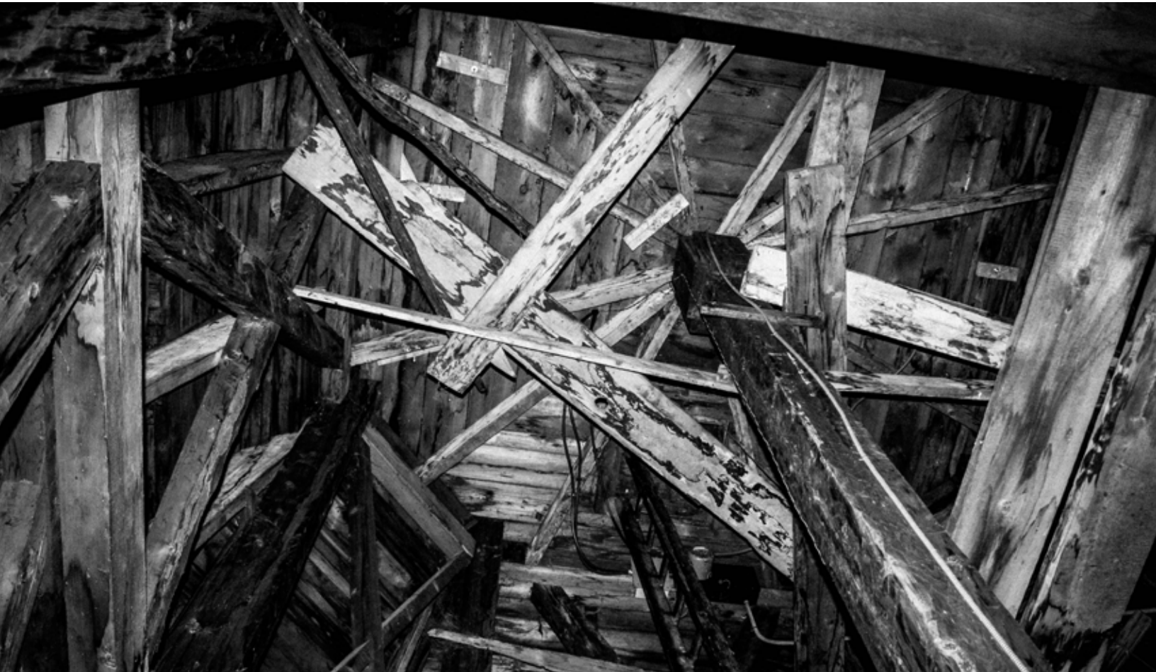
La charpente du clocher de l'église de Saint-Raphaël. (Photographie : Éric Vermette, 2016)
